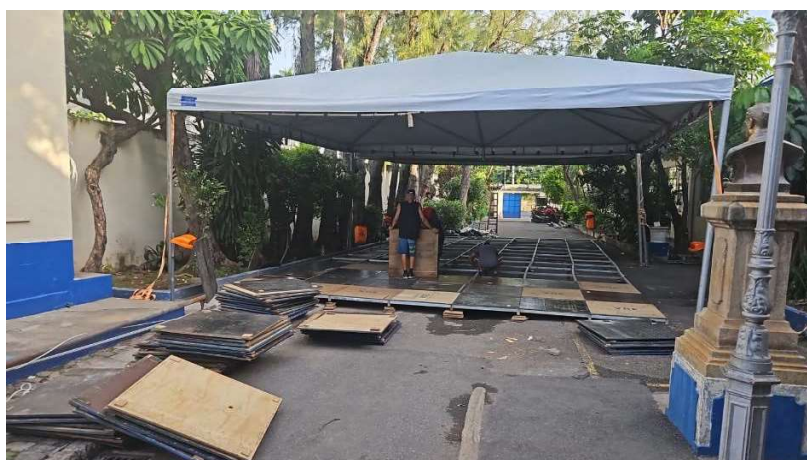
Figura 15 - Instalação das tendas e octanorms no CJV
