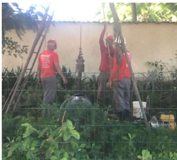
Figuras 12 – Obras de estrutura no CJV
