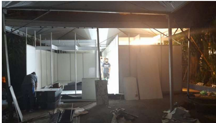
Figura 16 - Montagem de áreas para consultórios e recepção
