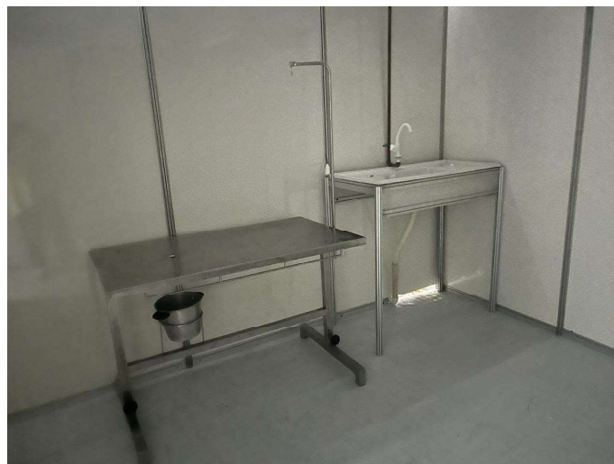
Figura 17 – Montagem dos Consultórios
