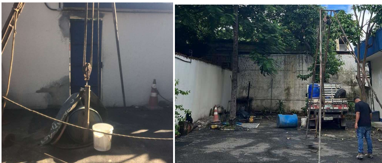
Figuras 10 e 11 – Início das obras de estrutura no CJV
