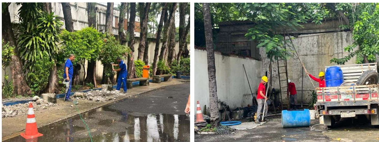
Figuras 8 e 9 – Etapas de retirada dos bancos e obras de estrutura no
