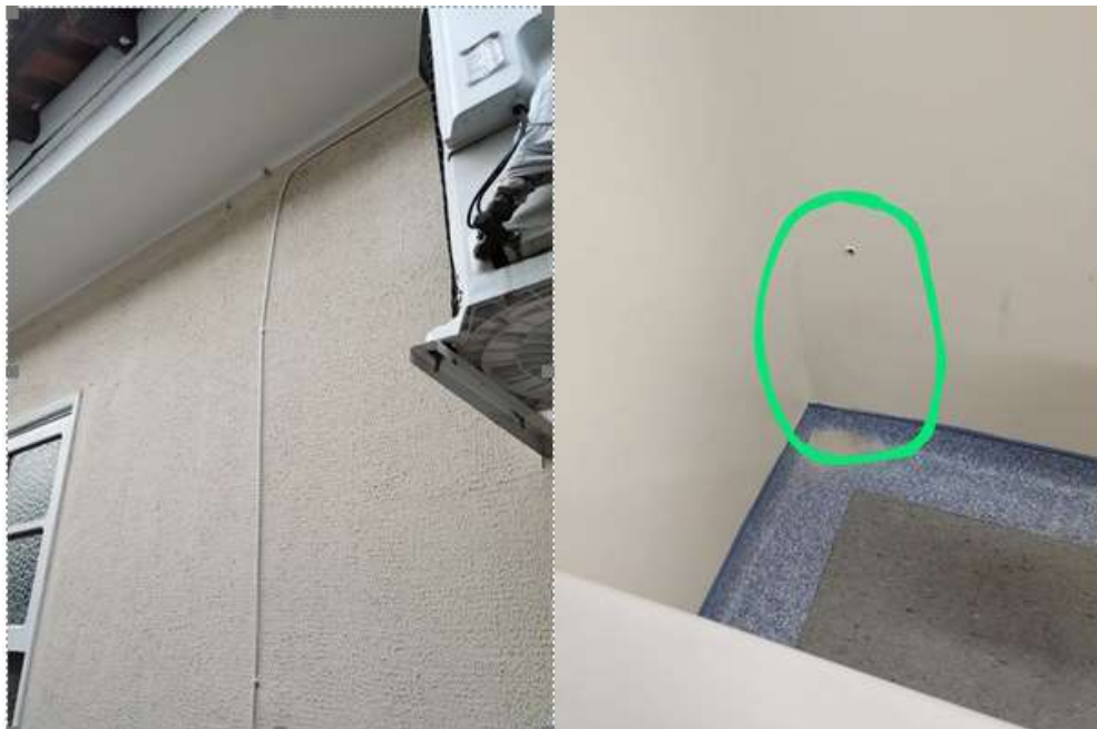
Figura 1. Instalação do serviço de internet pela concessionária na sala da gerência técnica.
