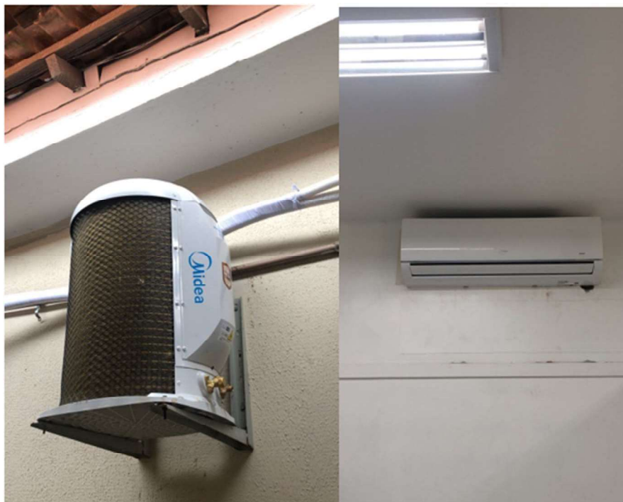
Figura 6. Instalação aparelho de ar condicionado na sala de radiologia.
