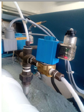
Válvula solenóide 2/2 vias 24Vcc
