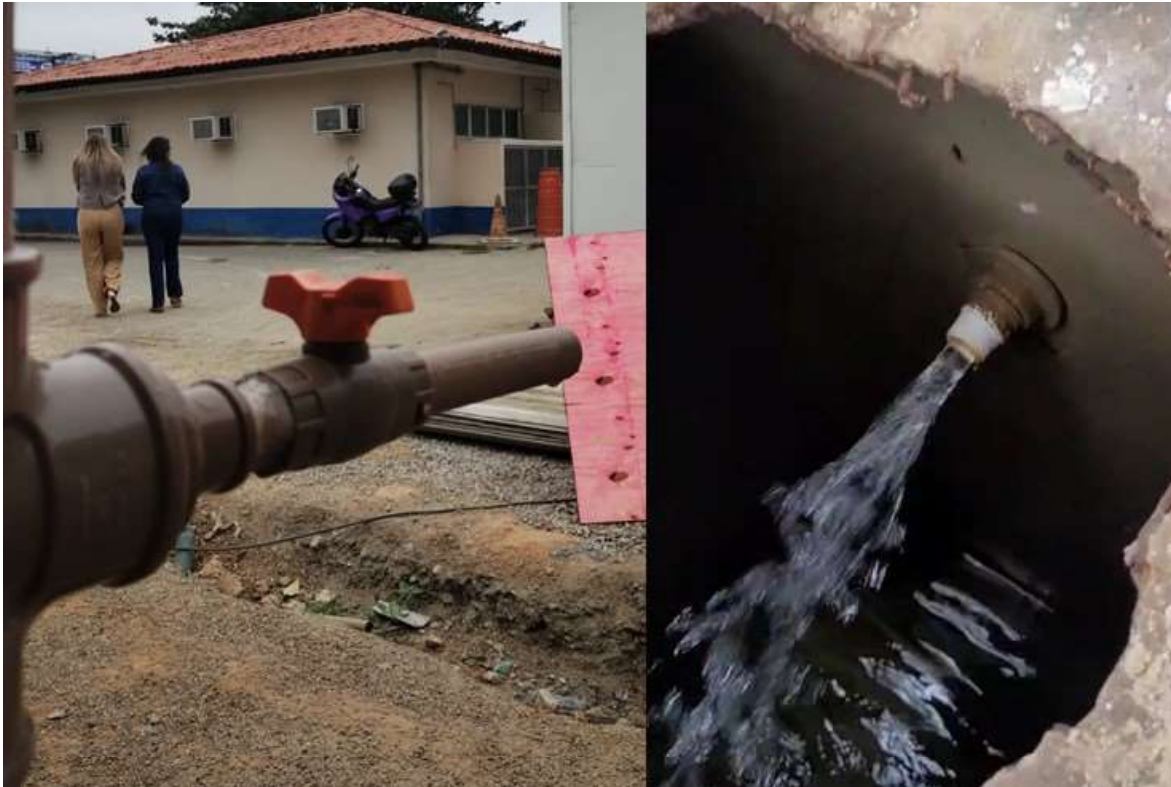
Figura 12. Registro de água criado como alternativa para abastecer o setor de clínica cirúrgica a esquerda. Vazão de abastecimento na cisterna após correção da obstrução do cano.
