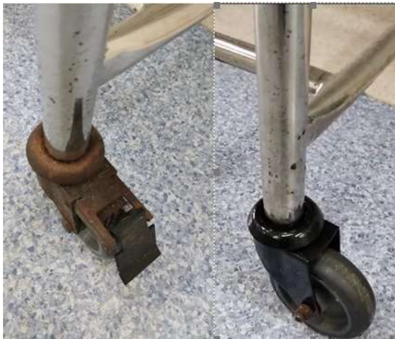
Figura 7. Rodízios antes e após manutenção e pintura.
