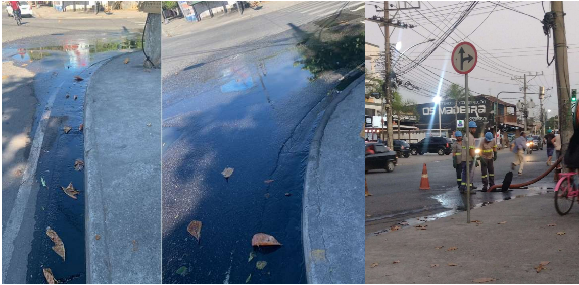
Figura 7. Obstrução na drenagem de esgoto em frente ao CCZ.
