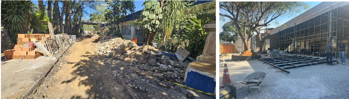
Figuras 14 e 15 – Pátio e Fachada do Hospital
