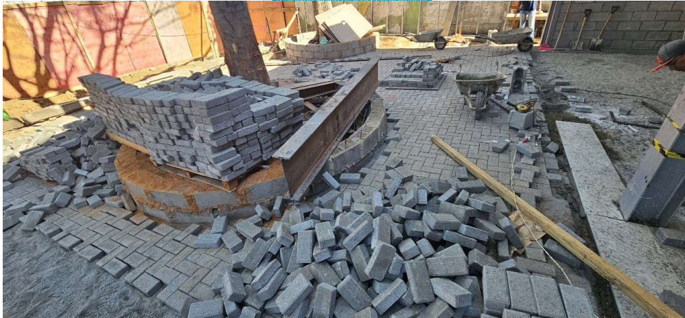
Figura 18 – Pavimentação da fachada do Hospital
