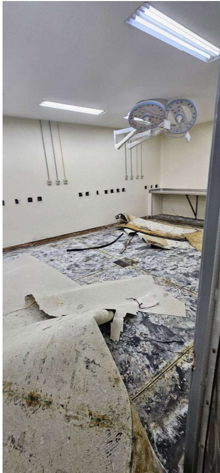
Figuras 19 e 20 – Piso do Centro Cirúrgico e Instalação do Foco na Sala Vermelha
