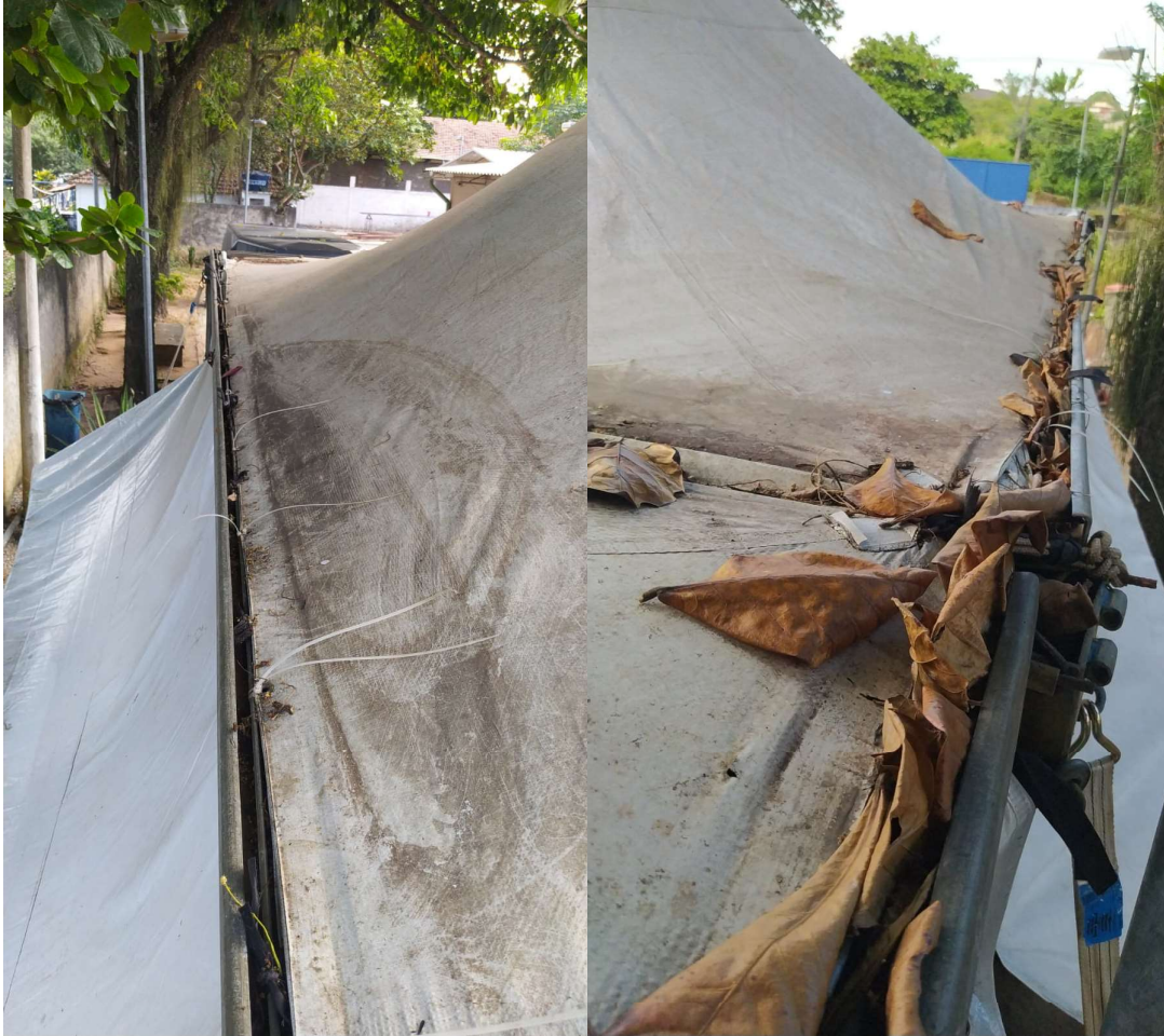
Figura 2. Calha antes e após limpeza.
