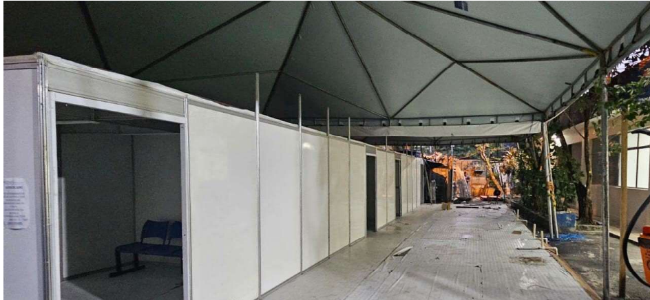
Figura 7 - Desmontagem Octanormes Consultórios de Clínica Médica e Recepção.
