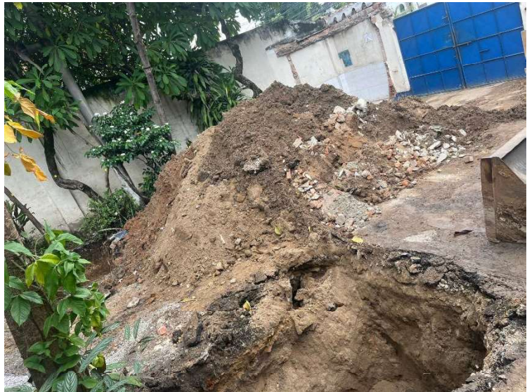
Figuras 15 e 16 – Obras no CJV
