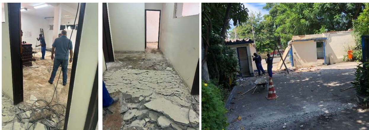
Figuras 25 a 27 – Obras no CJV
