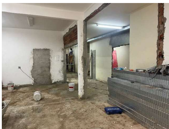
Figura 20 – Obras no CJV
