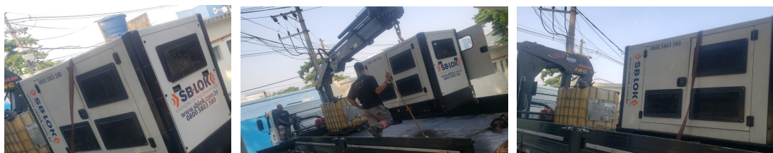
Figuras 3 a 5 - Retirada do gerador do Bloco da Clínica Médica
