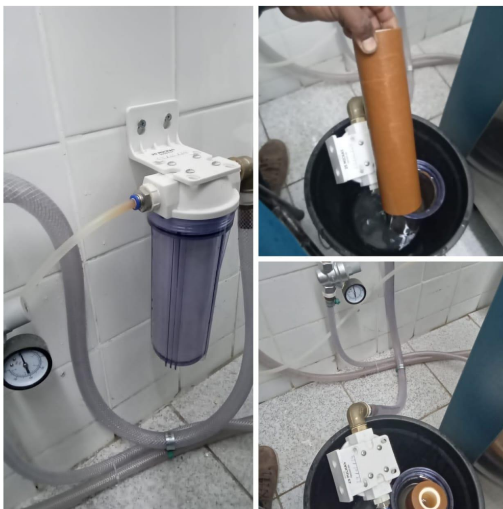
Figura 2. Troca do filtro de água que abastece o autoclave.
