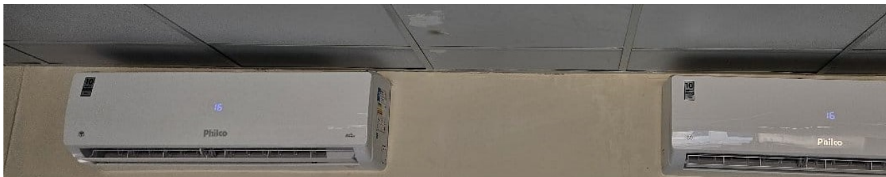
Figura 2 – Instalação dos Ar-condicionados na Recepção do Centro Cirúrgico
