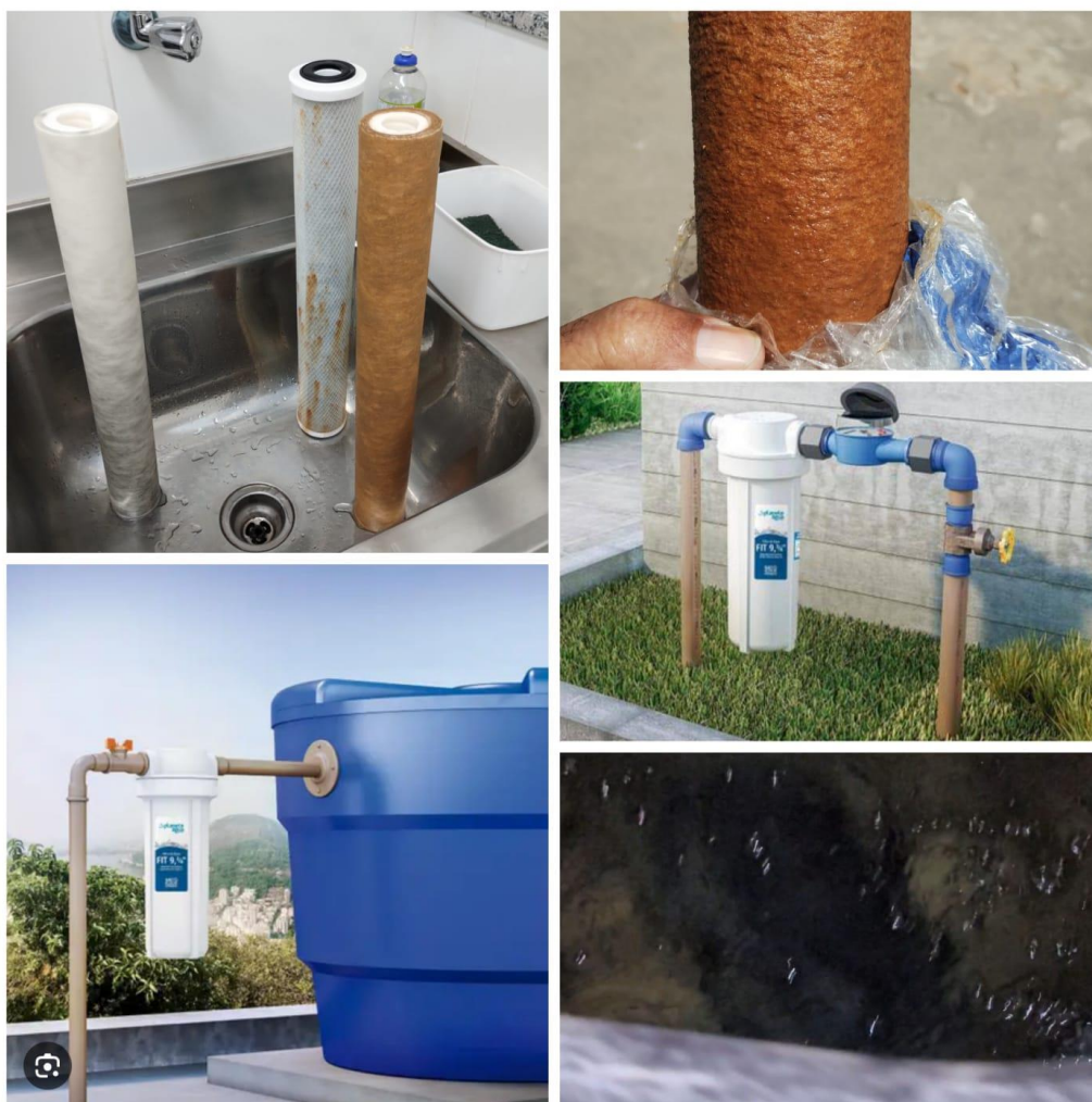
Figura 5. Troca dos filtros de água da unidade CCZ e imagens que apresentam uma solução para minimizar tais eventos (filtros instalados antes dos reservatórios).
