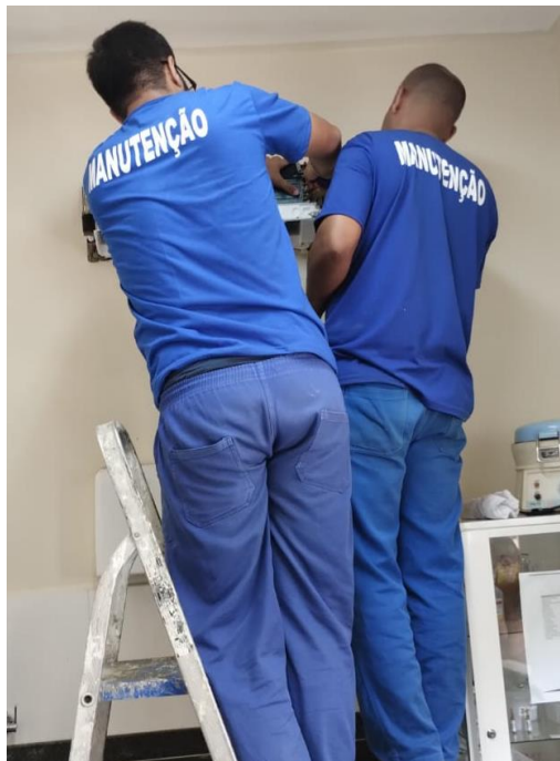
Figura 30. Manutenção do aparelho de ar condicionado.
