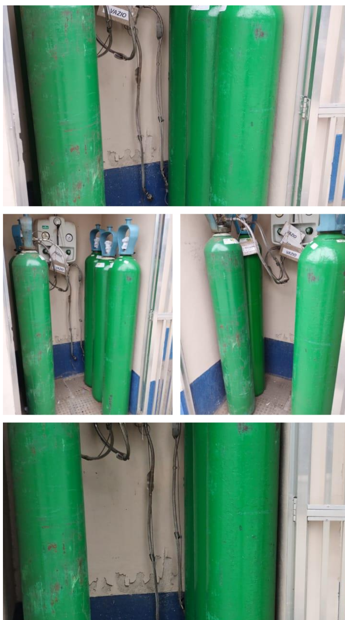
Figura 1. Central de gases medicinais apresentando os cinco cilindros de 10 mm 3 .
