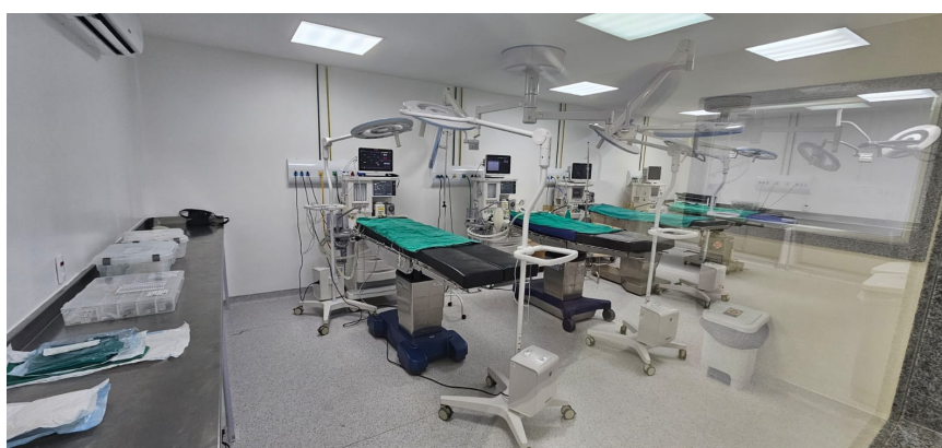
Figura 25. Sala 3 – Centro Cirúrgico.
