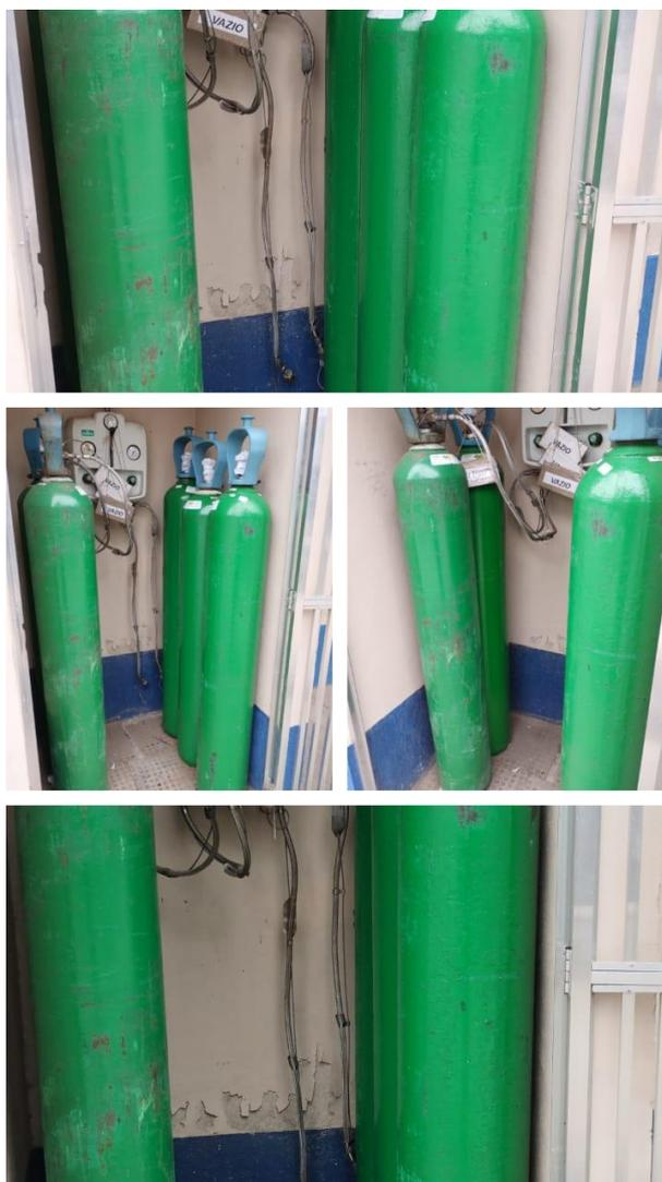
**Figura 1. Central de gases medicinais apresentando os cinco cilindros de 10 mm<sup>3</sup>.**
