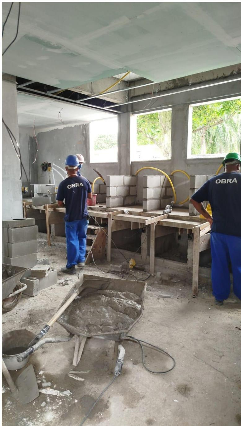
Figura 32. Construção das baias/gaiolas conforme previsto.
