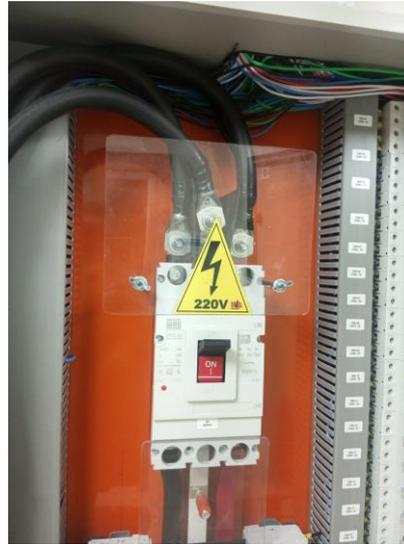
**Figuras 10 a 11 – Identificação dos disjuntores do Centro Cirúrgico**
