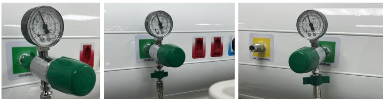
**Figuras 02 a 04 – Instalação das Válvulas de Oxigênio de Rede nas 3 Salas de Cirurgia**
