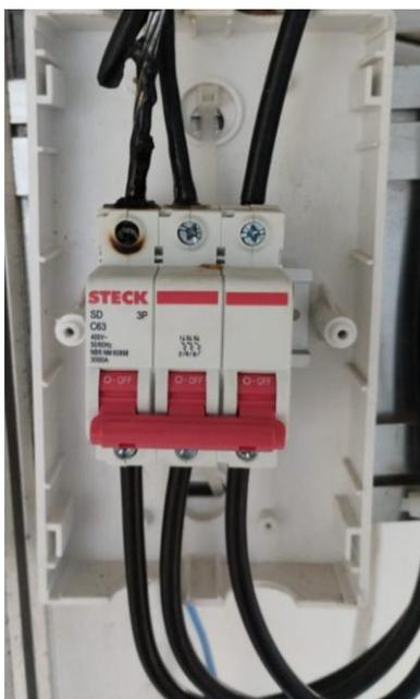
Figura 21 Disjuntor localizado no sistema elétrico do octanorme.
