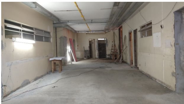
Figuras 10 e 20 – Obras no CJV
