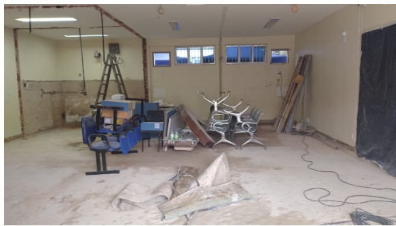
Figuras 15 e 16 – Obras no CJV
