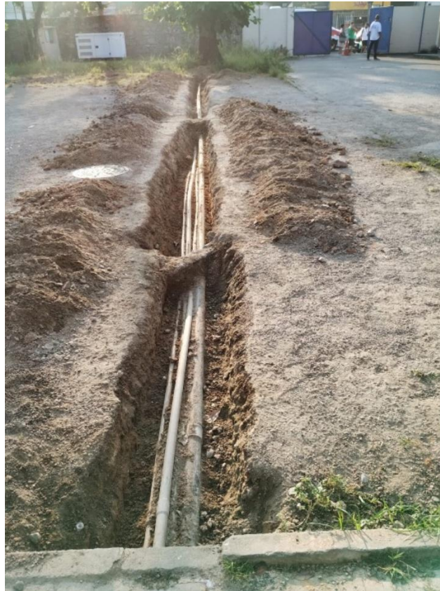
Figura 36. Escavações no terreno da unidade CCZ.
