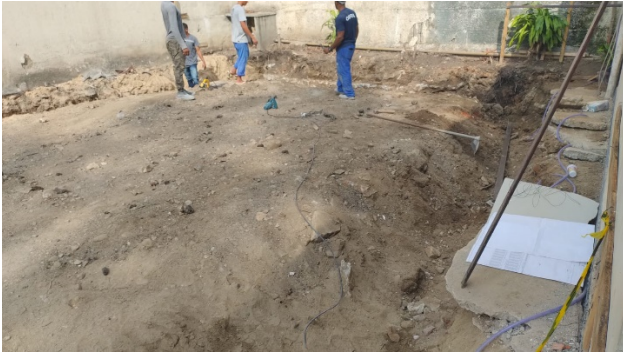
Figuras 13 e 14 – Obras no CJV
