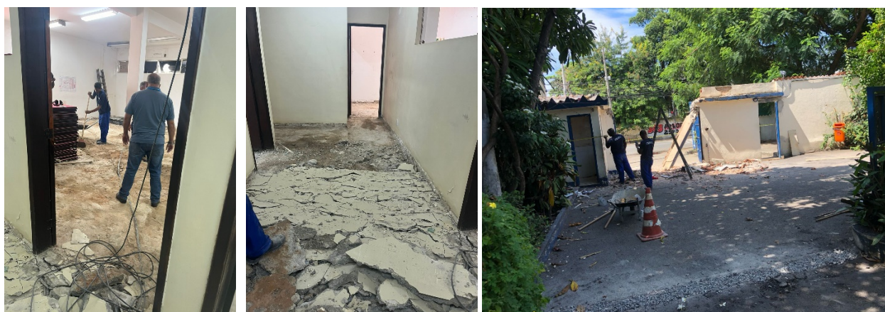
Figuras 10 a 12 – Obras (áreas interna e externa) no CJV
