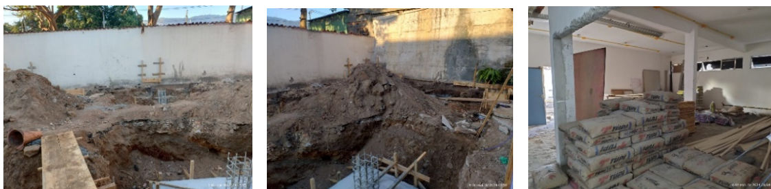
Figuras 07, 08 e 09 – Sala de Espera do Centro Cirúrgico em obras no CJV
