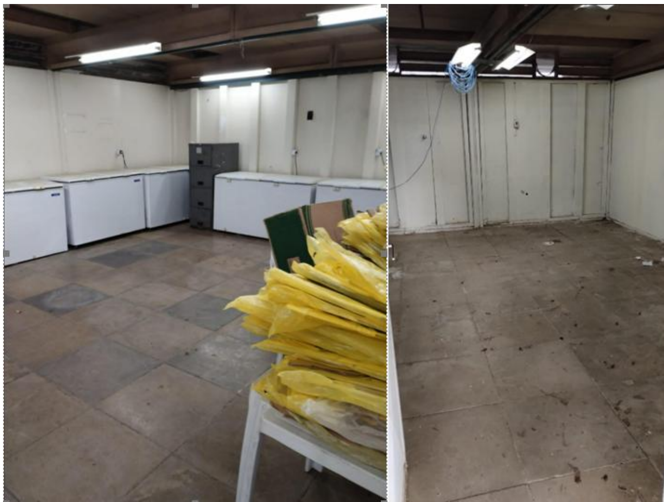
Figura 10. Desocupação da primeira sala do anexo da unidade CCZ.
