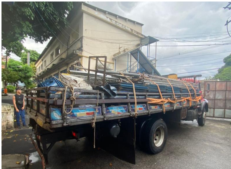
Figura 9 – Chegada das estruturas metálicas para montagem das tendas e octanorms
