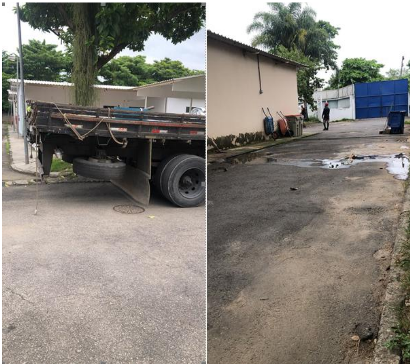
Figura 12. Caminhão aguardando a descarga das ferragens do octanorme (imagem a esquerda), área escolhida para montagem do octanorme (direita).
