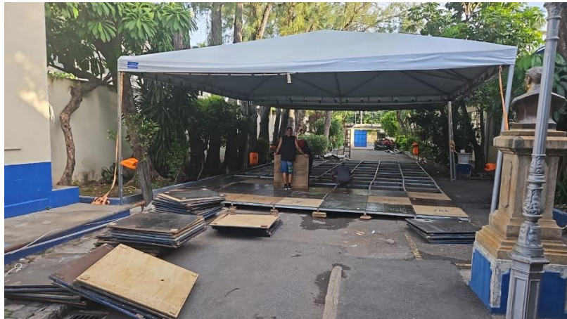
Figura 11 - Instalação das tendas e octanorms no CJV
