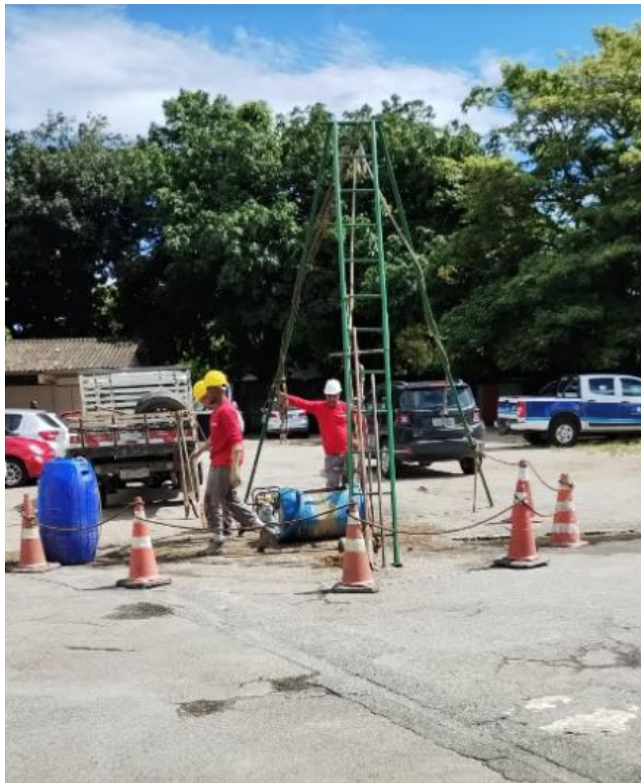
Figura 11. Técnicos em atuação para perfuração do solo da unidade CCZ.
