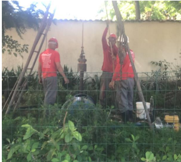
Figuras 8 – Obras de estrutura no CJV
