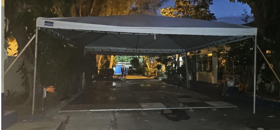
Figura 10 - Instalação das tendas e octanorms no CJV
