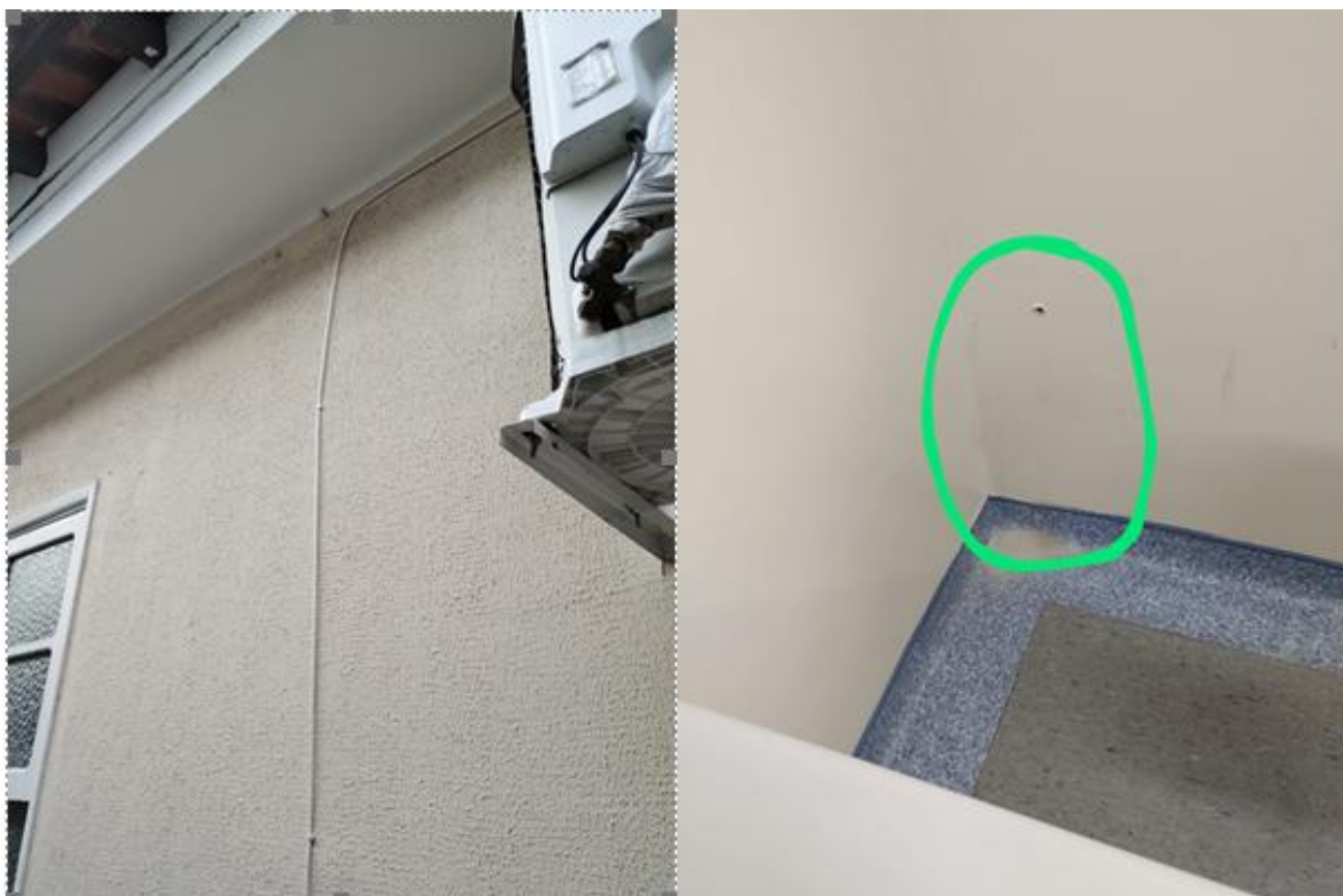
Figura 1. Instalação do serviço de internet pela concessionária na sala da gerência técnica.
