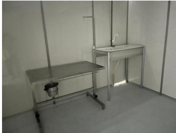
Figura 13 – Montagem dos Consultórios
