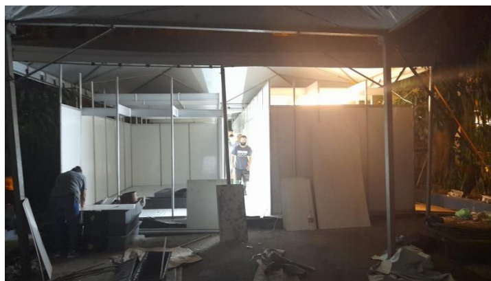
Figura 12 - Montagem de áreas para consultórios e recepção.
