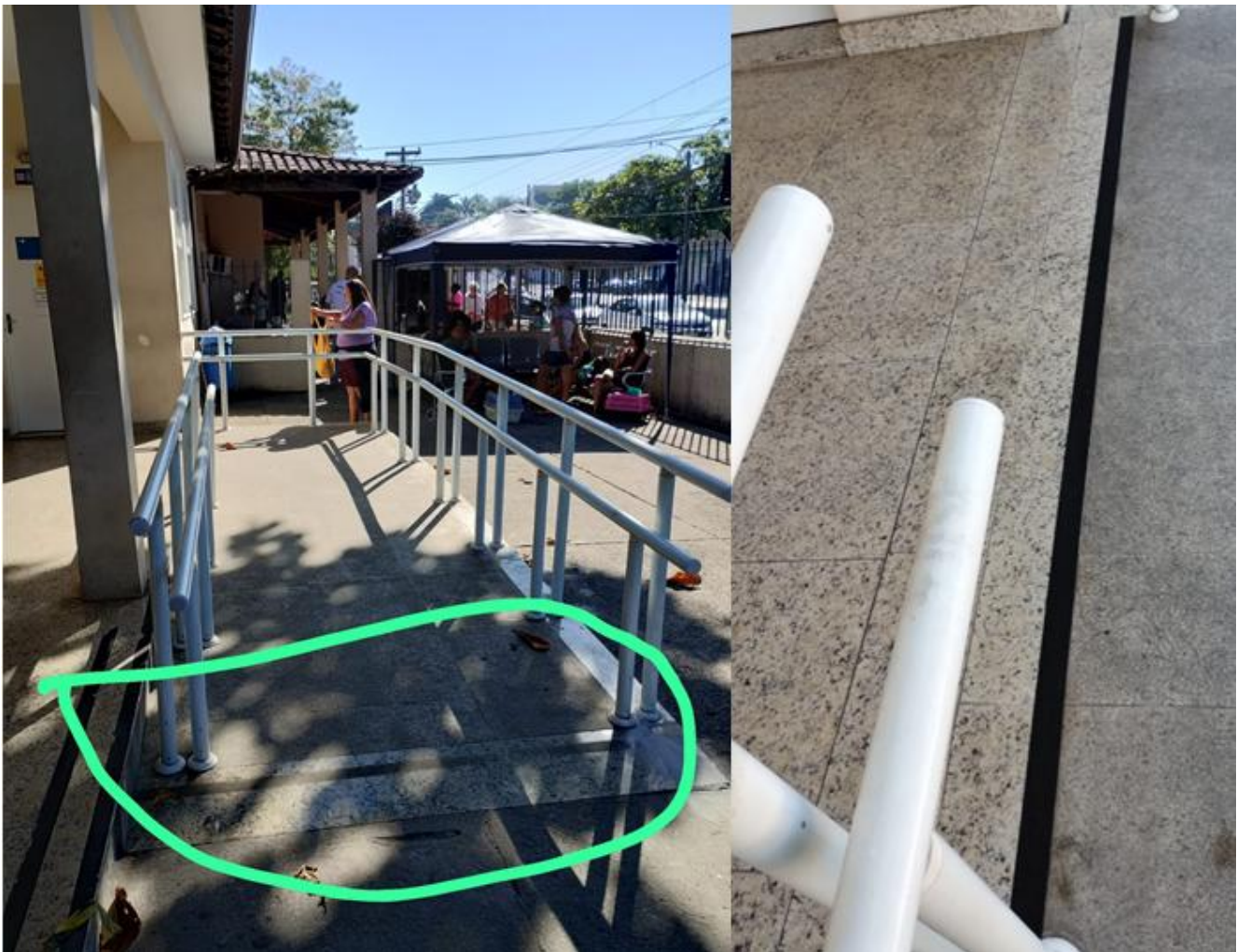
Figura 9. Colocação de fitas antiderrapantes em locais estratégicos para segurança dos transeuntes.
