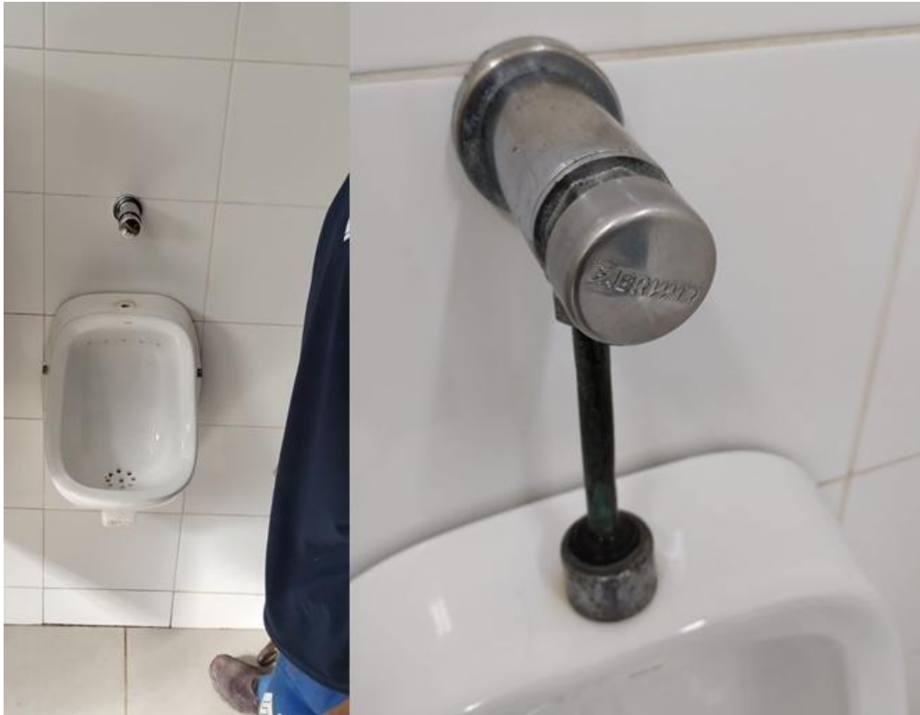
Figura 4. Manutenção de lavatório com regulagem a menor na oferta de água.
