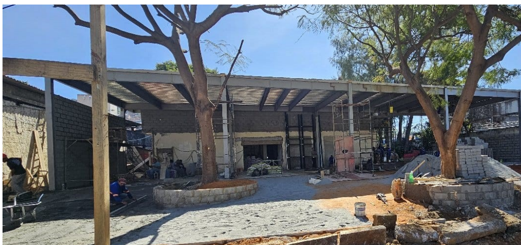
Figura 13 – Pavimentação e fundação da fachada do Hospital
