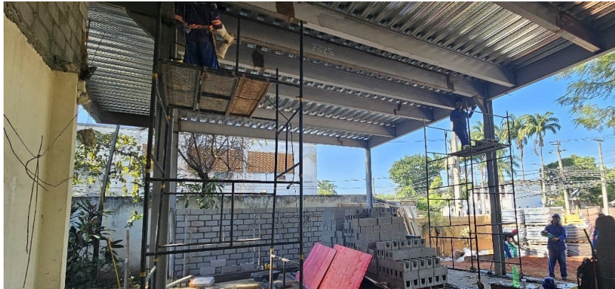
Figura 7 – Fundação da Sala da Espera
