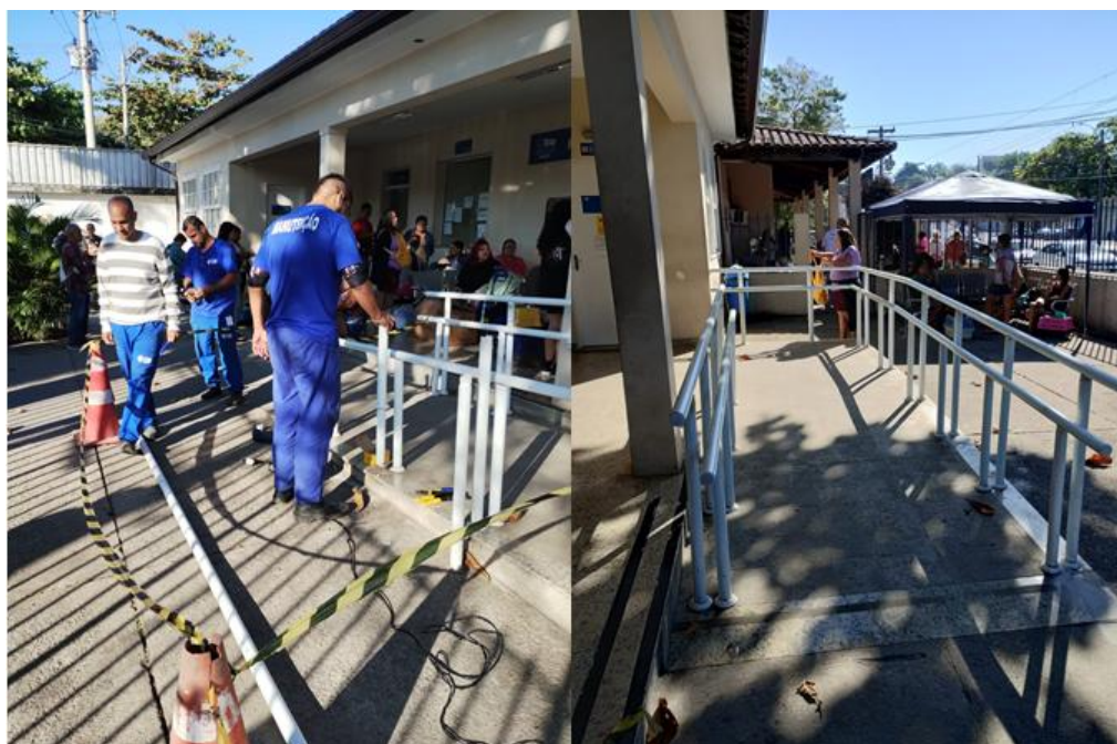
Figura 8. Manutenção dos corrimões do setor da clínica médica.
