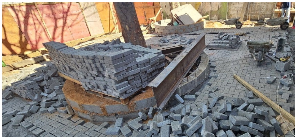
Figura 14 – Pavimentação da fachada do Hospital
