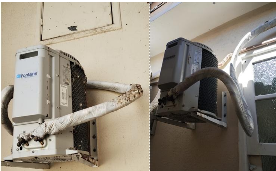
Figura 6. Limpeza das condensadoras dos aparelhos de ar condicionado, antes e depois.
