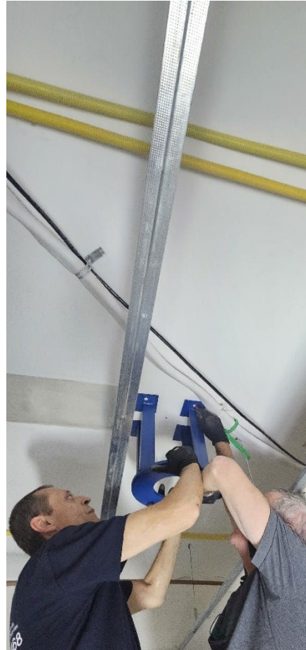
Figuras 15 e 16 – Piso do Centro Cirúrgico e Instalação do Foco na Sala Vermelha
