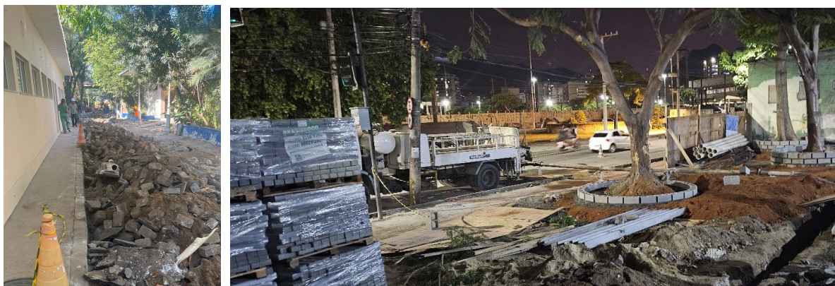
Figuras 11 e 12 – Pavimentação e fundação da fachada do Hospital
