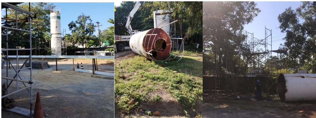
Figura 20. Imagem onde se vê o castelo na foto (a esquerda) e após a derrubada da sua metade e o desmanche total, aguardando a retirada.
