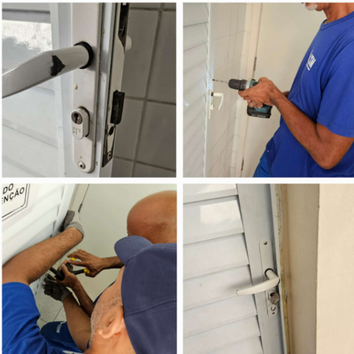
Figura 3. Manutenção da equipe em ação na substituição da fechadura defeituosa.
