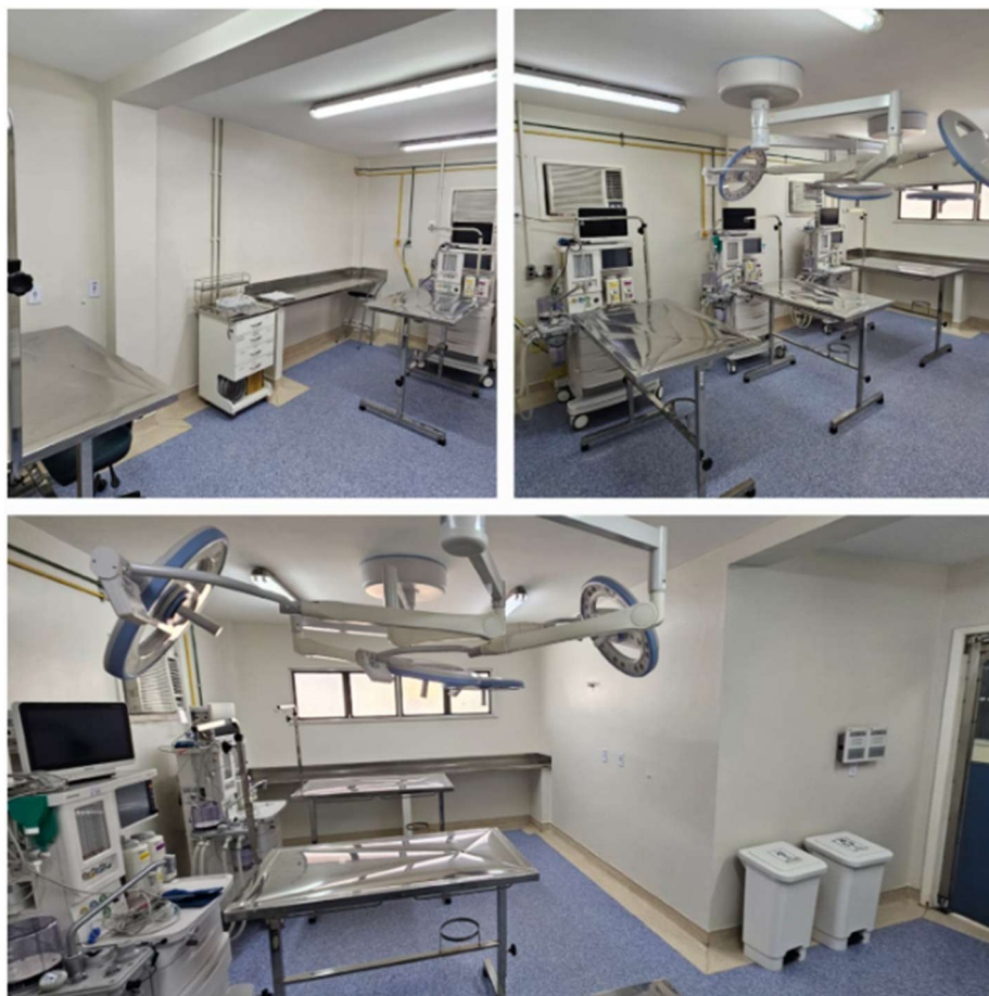
Figura 2. Manutenção predial da parte interna do setor de cirurgia na sala 01, com os devidos cuidados.
