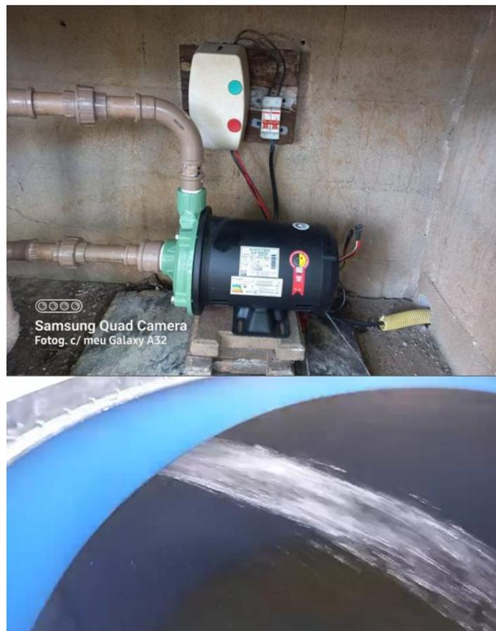
**Figura 3. Instalação de bomba atendendo o abastecimento da unidade CCZ.**
