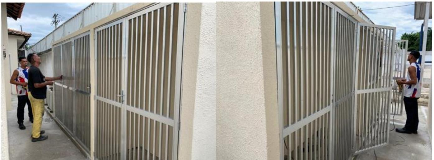
Figura 34. Portas de alumínio colocadas na central de gases medicinais do anexo clínico.
