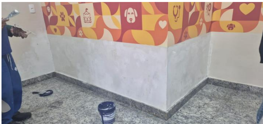
Figura 02. Correção de infiltração na sala de espera de esporotricose, com reparos estruturais e acabamento final (10/07/2025) HMOVJV.
