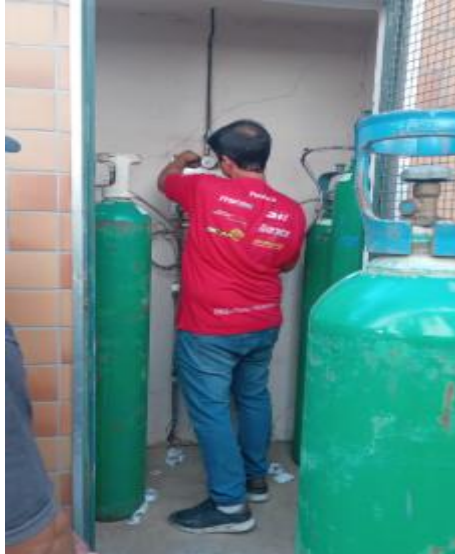
Figura 13. Visita técnica à central de oxigênio para inspeção e ajuste no registro, garantindo o funcionamento seguro do sistema (21/07/2025).
