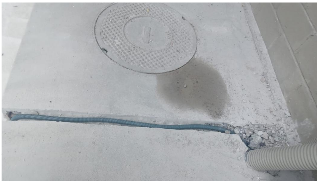
Figura 40. Construção da canaleta de alimentação do Totem Externo (220 V).
