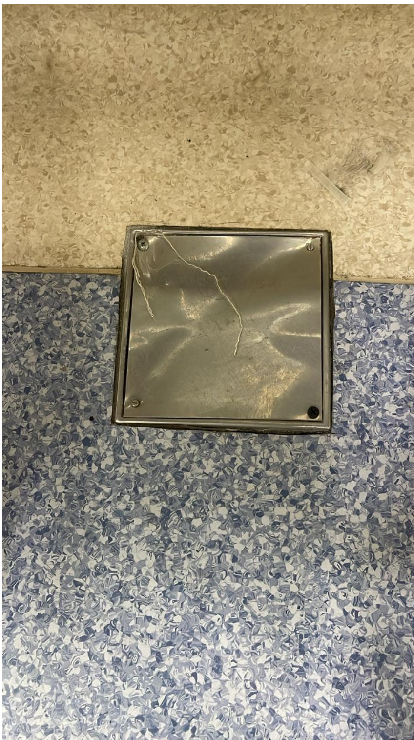
Figura 21. Fixação da tampa do ralo.
