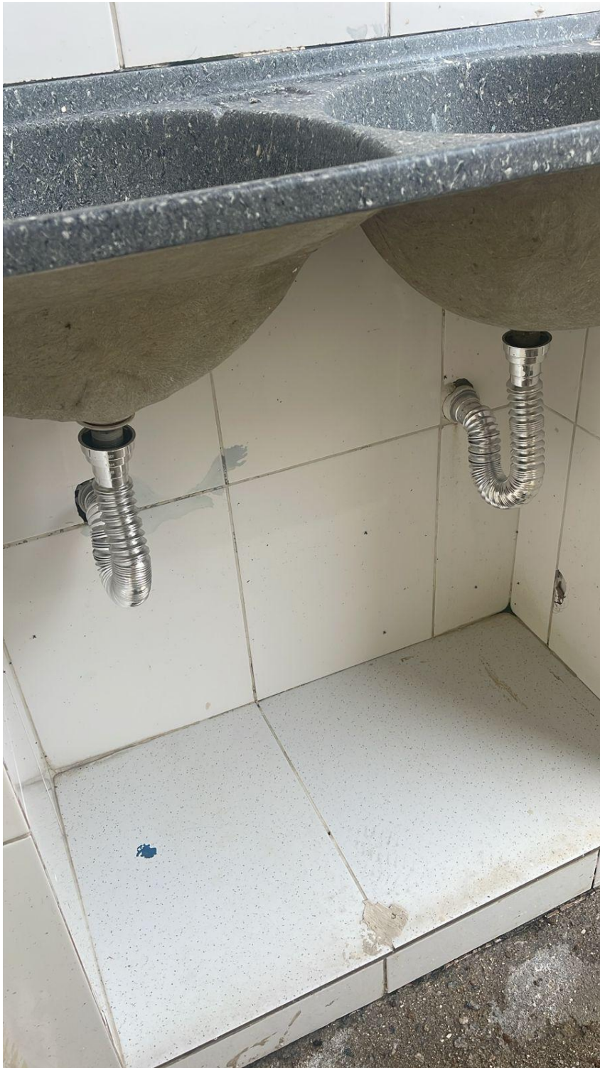
Figura 13: Sifão trocado.
