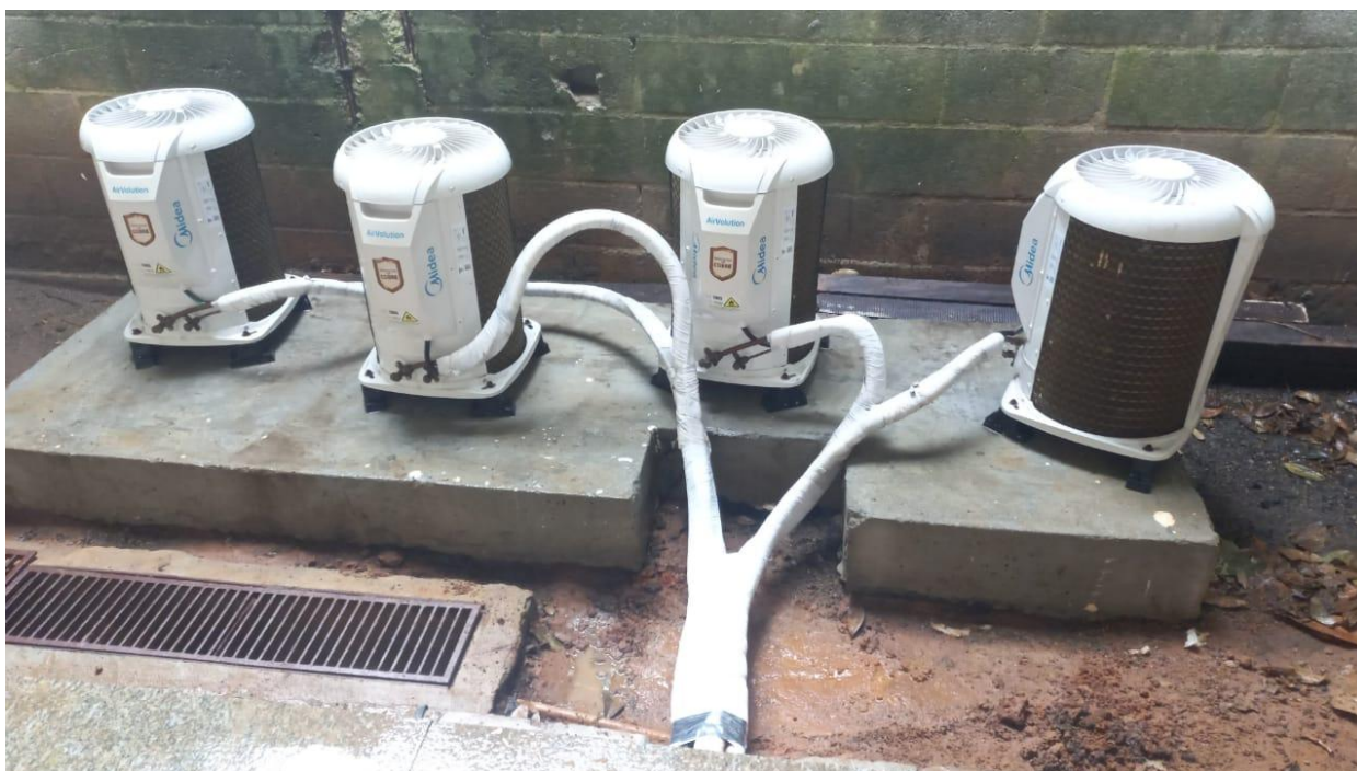
Figura 18: Conclusão da limpeza dos compressores.
