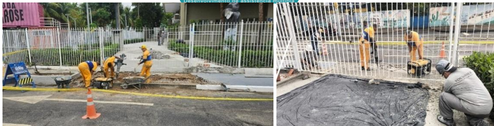
Figuras 38 e 39. Construção da calçada, via Prefeitura - Conservação, na entrada da área de serviços e arremate lateral da rampa.
