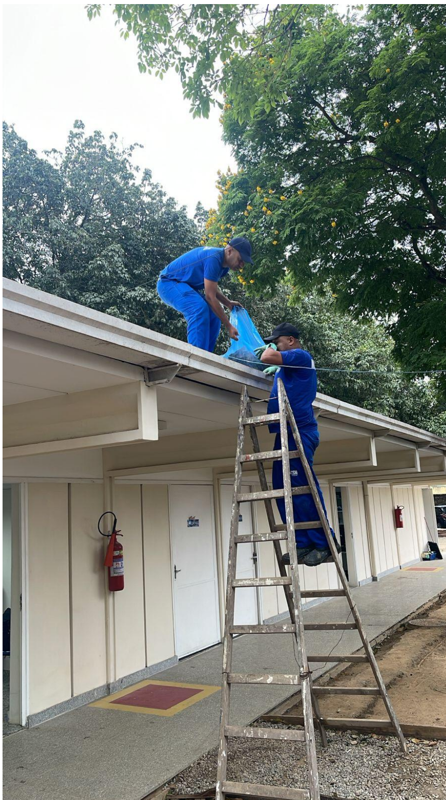
Figura 15. Limpeza das calhas de chuva.
