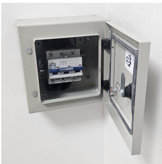
Figura 51. Quadro com novo disjuntor doa Autoclave do HMVSFA.
