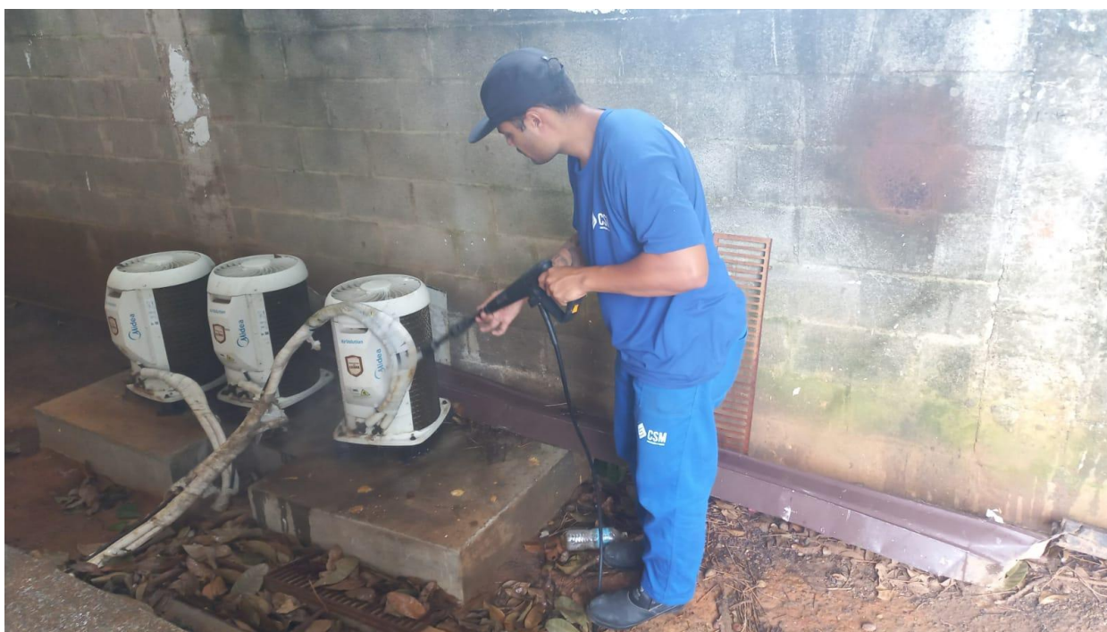
Figura 17: Técnico realizando a limpeza dos compressores de ar-condicionado.
