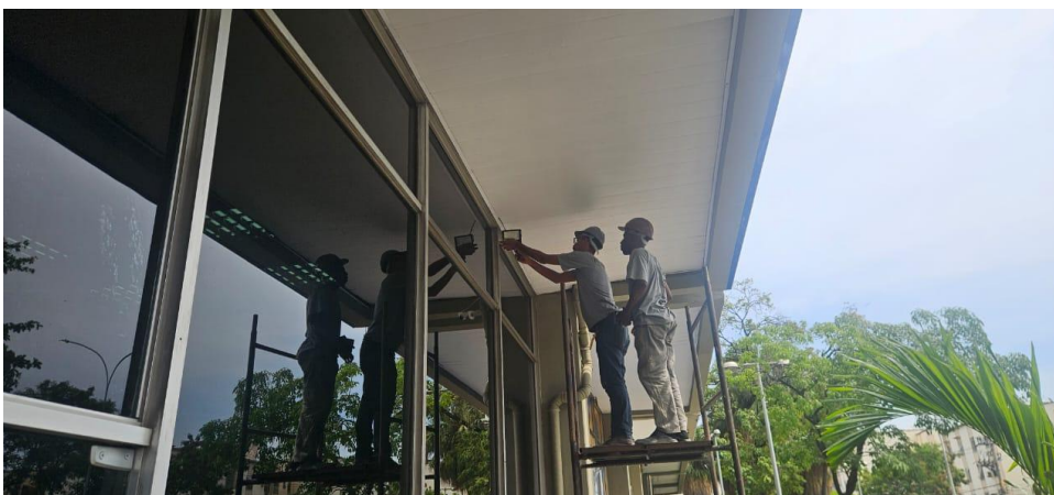
Figura 23. Troca dos refletores da área externa do HMVSFA.
