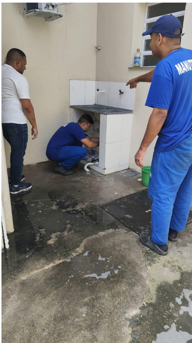
Figura 12: troca de sifão do tanque.
