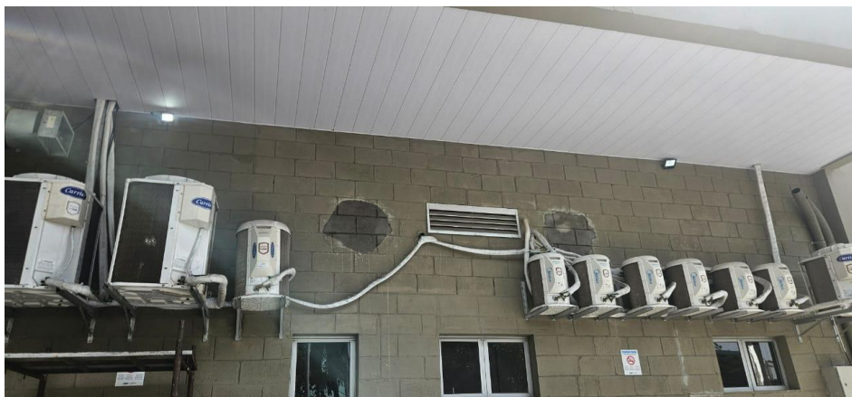
Figura 19. Fechamento dos espaços onde estavam os antigos exaustores na entrada da área de serviços do HMVSFA.
