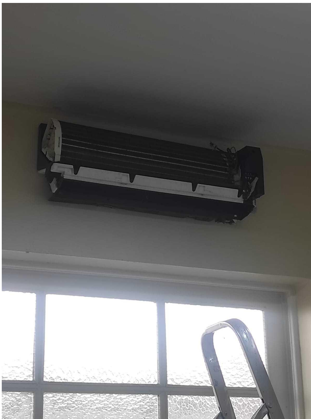
Figura 5. Ar condicionado em processo de manutenção.
