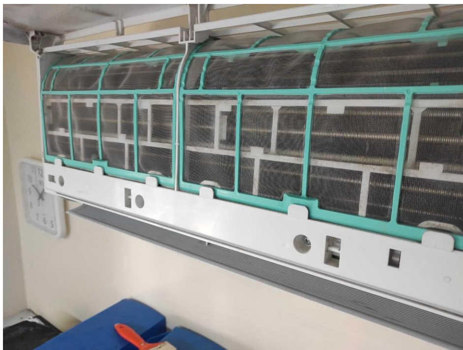
Figura 8. Filtro de ar devidamente limpo e já montado no equipamento.
