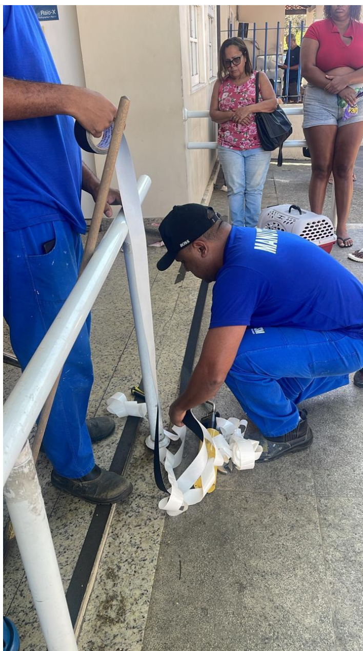
Figura 19. Substituição da fita antiderrapante da chegada a recepção da clínica médica.
