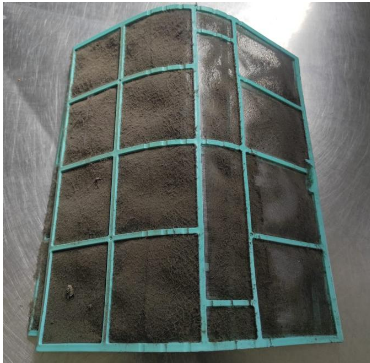
Figura 20. Antes da limpeza.
