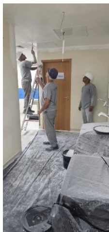
Figuras 43 a 45 – Reparo do teto do ambiente do Centro Cirúrgico (Forro e pintura) do HMVSFA pela Empresa Fournier.
