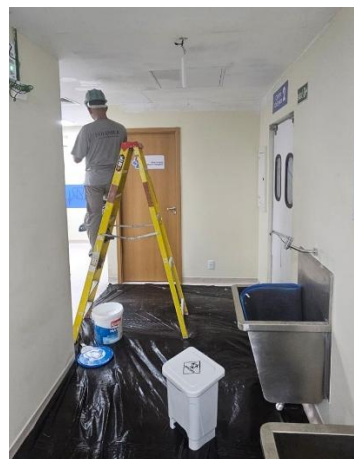
Figuras 40 a 42 – Reparo do teto do ambiente do Centro Cirúrgico (Forro e pintura) do HMVSFA pela Empresa Fournier.
