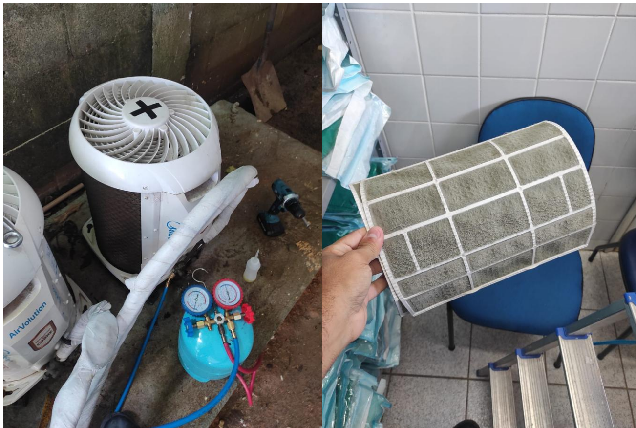
Figura 6. Manutenção e limpeza de filtros de ar-condicionado.
