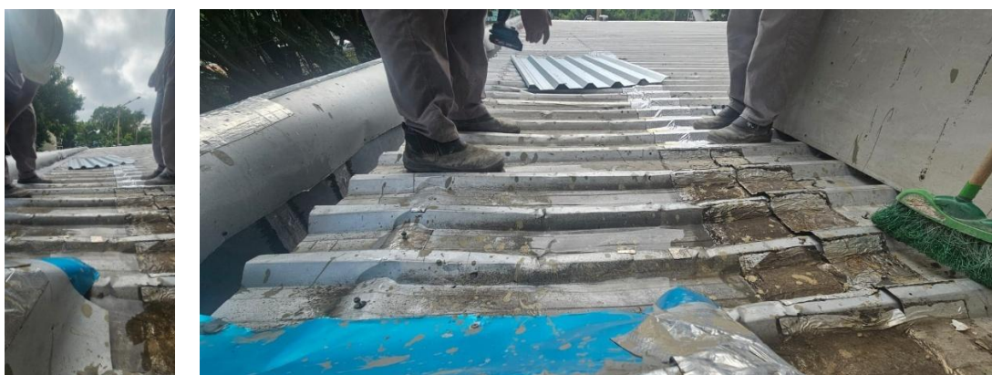
Figuras 27 e 29 – Reparo (substituição das telhas amassadas) no telhado do HMVSFA pela Empresa Fournier.
