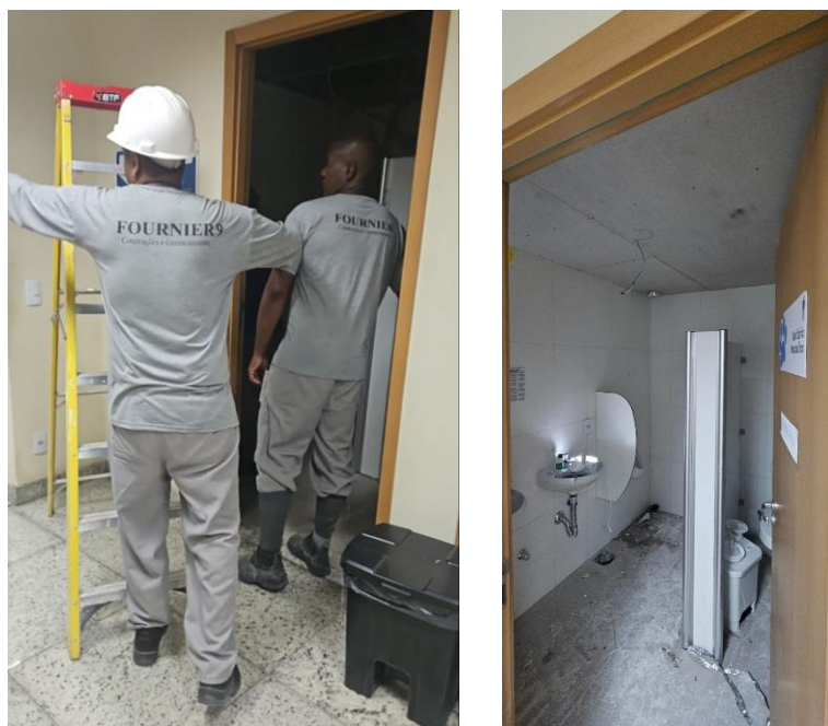
Figuras 09 e 10 – Reparo na tubulação de águas fluviais e forro do lavabo masculino do HMVSFA.
