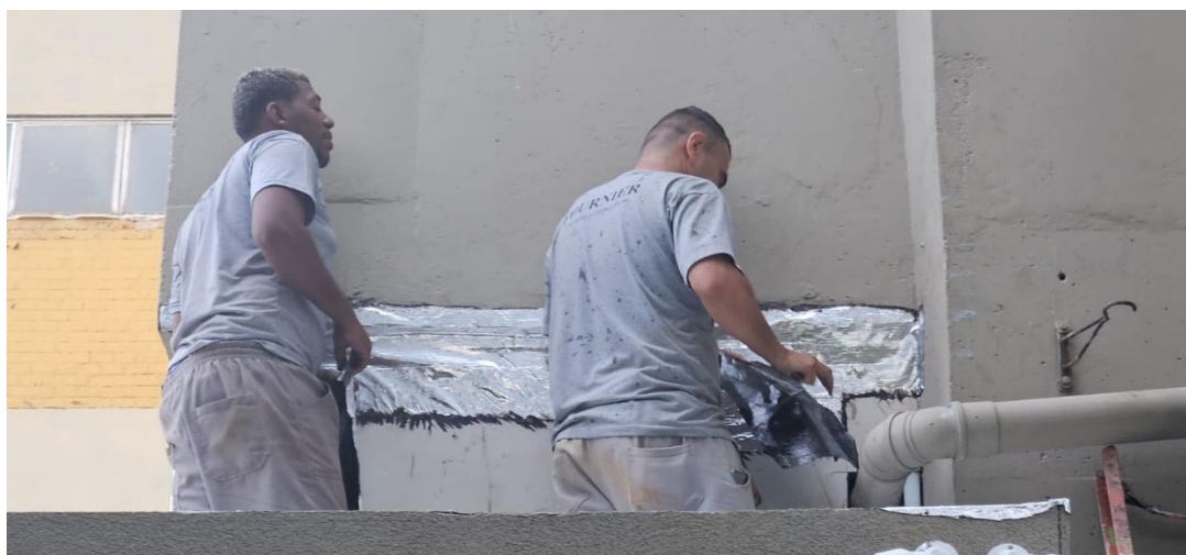
Figuras 29 – Reparo (instalação da manta asfáltica) na área do telhado do HMVSFA pela Empresa Fournier.
