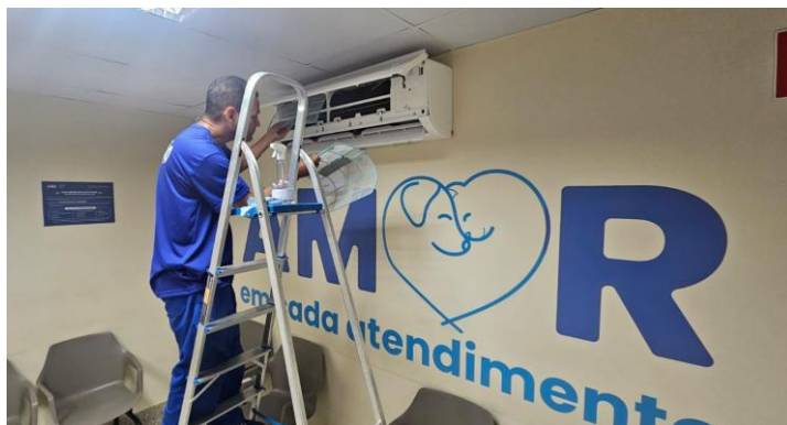
Figuras 01 e 02 – Limpeza dos filtros dos aparelhos de ar-condicionado (manutenção preventiva) do HMVSFA.
