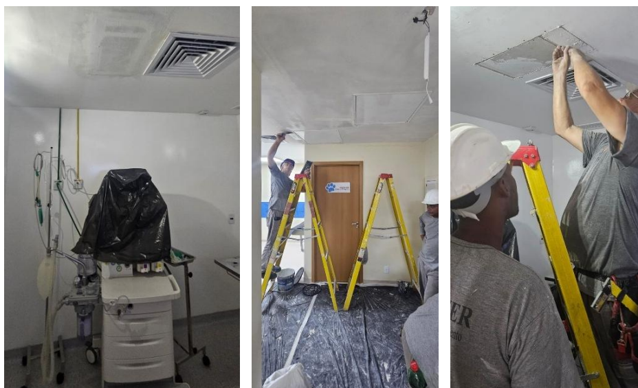
Figuras 33 a 35 – Reparo do teto do ambiente do Centro Cirúrgico (Forro e Pintura) do HMVSFA pela Empresa Fournier.
