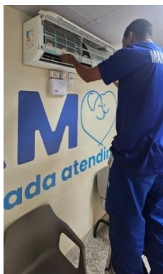
Figuras 01 e 02 – Limpeza dos filtros dos aparelhos de ar-condicionado (manutenção preventiva) do HMVSFA.
