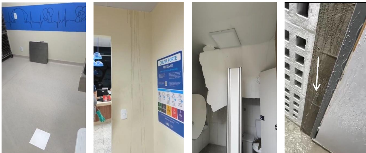
Figuras 05 a 08 – Pontos de saída de água, em decorrência de rompimento de tubulação de águas fluviais e queda do forro no lavabo masculino do HMVSFA.
