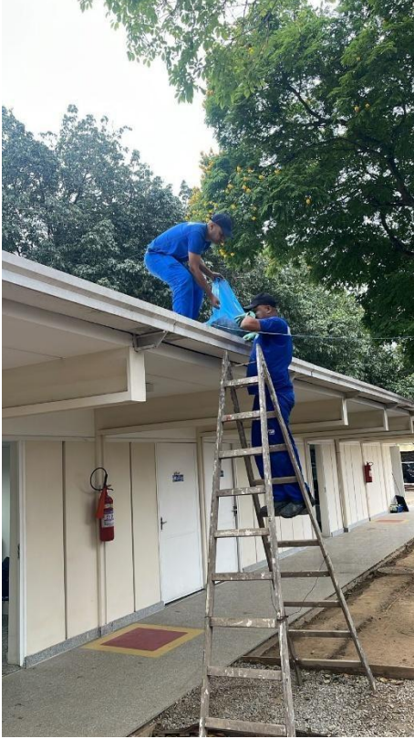
Figura 17. Limpeza de calhas de chuva.
