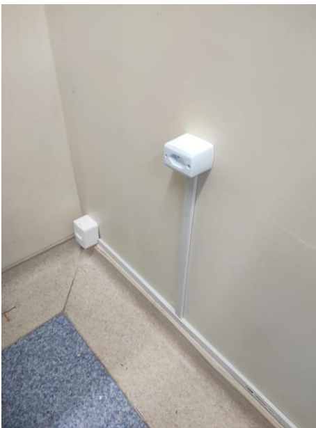
Figura 18. Instalação de tomada.
