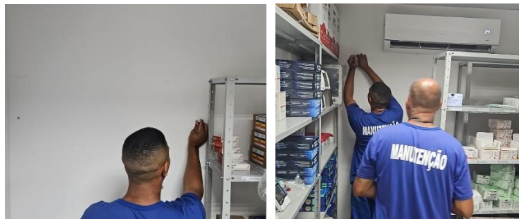
Figuras 20 e 21 – Fixação das Estantes do Almoxarifado e da Farmácia do HMVSFA.
