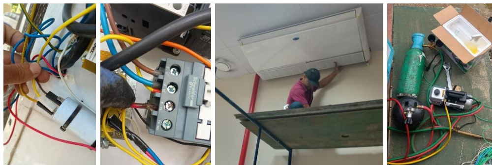
Figuras 12 a 15 – Manutenção nos aparelhos de ar-condicionados do HMVSFA.
