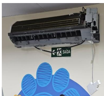
Figura 16 – Manutenção nos aparelhos de ar-condicionados do HMVSFA.
