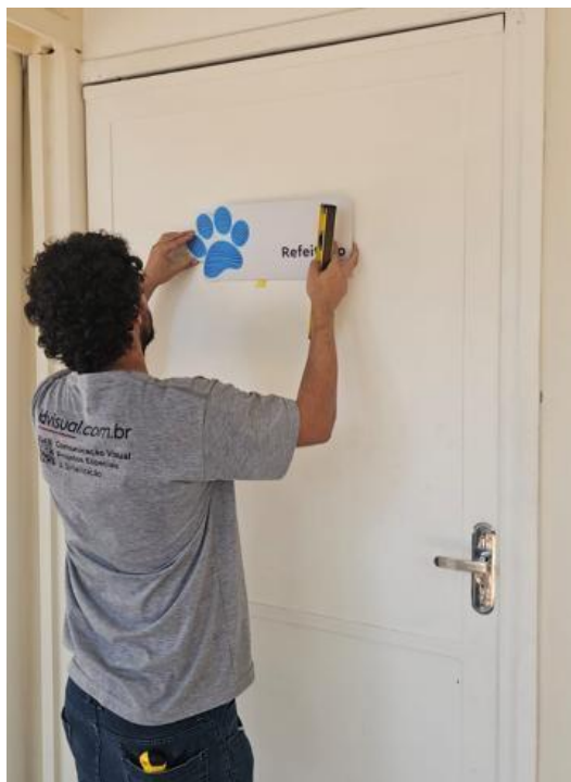
Figura 2. Fixação das placas de identificação.
