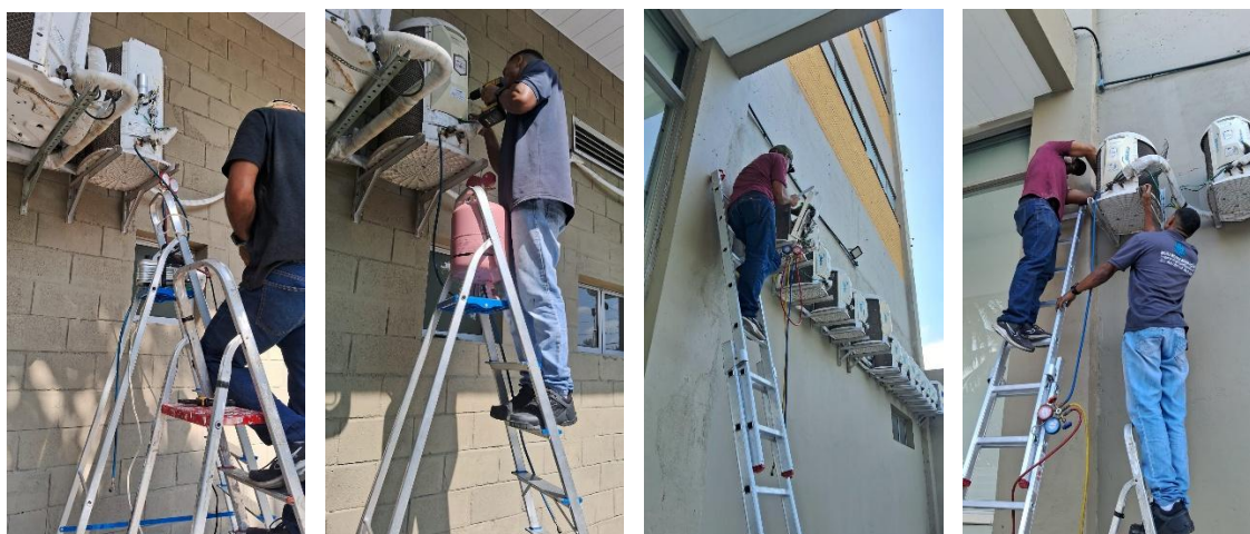
Figuras 03 e 06 – Manutenção corretiva de aparelhos de ar condicionado do HMVSFA.
