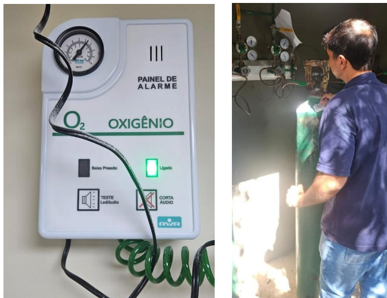
Figuras 01 e 02 – Regulagem de válvula de gás medicinal (oxigênio) do HMVSFA.
