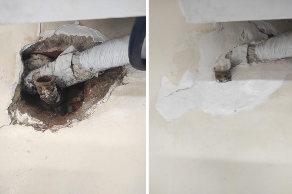
Figura 08. Correção do vazamento da drenagem do ar-condicionado.
