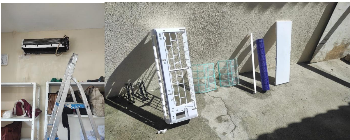
Figura 07. Limpeza e higienização do ar-condicionado.
