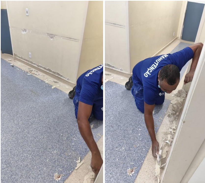
Figura 10. Correção das infiltrações dos rodapés e paredes do centro cirúrgico.
