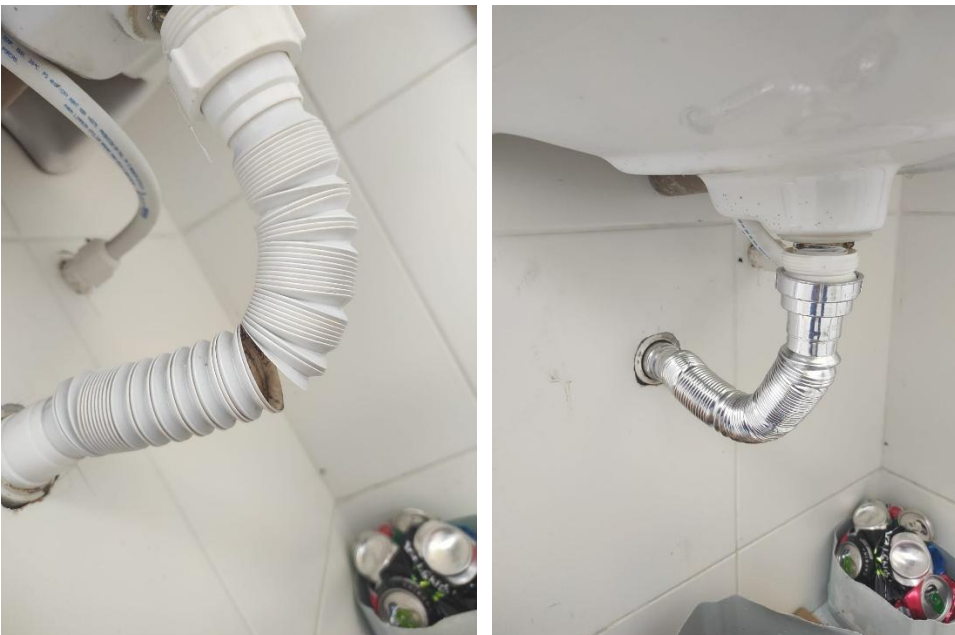
Figura 09. Troca do sifão.
