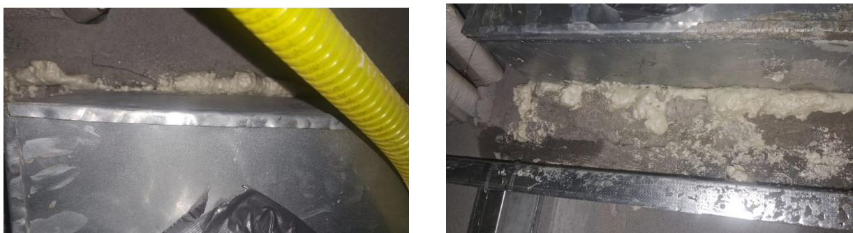
Figuras 08 e 09 – Manutenção corretiva (preenchimento com espuma expansiva) acima do forro da administração do HMVSFA.
