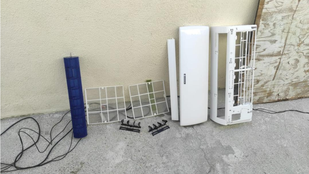
Figura 04. Manutenção de ar condicionado.
