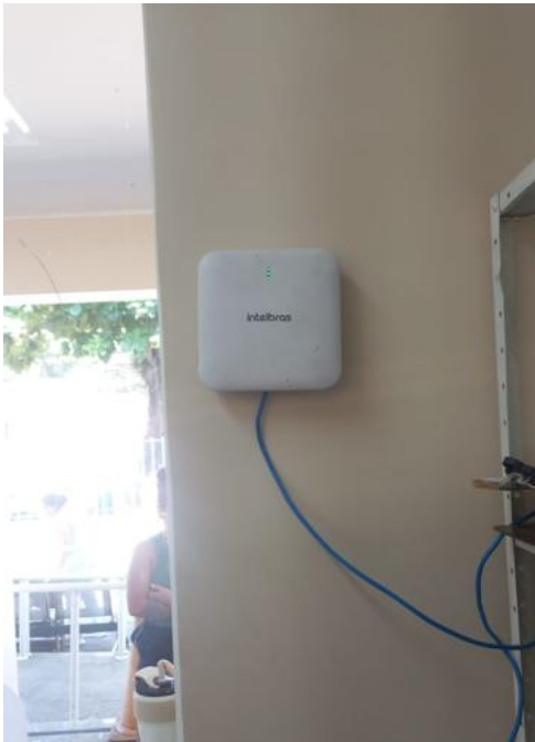
Figura 06. Fixação do modem.
